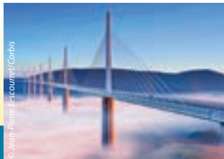
Η ψηλότερη γέφυρα του κόσμου, η οδογέφυρα του Millau (Γαλλία).
